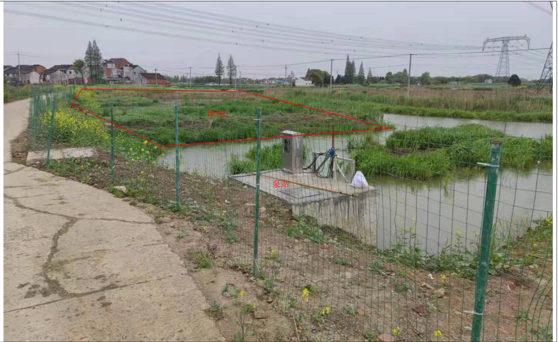
农业面源氮磷生态拦截净化工程堆场 2 现状
