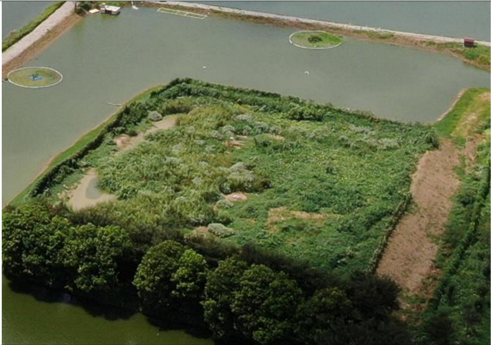
水产养殖尾水标准化治理工程淤泥堆场
