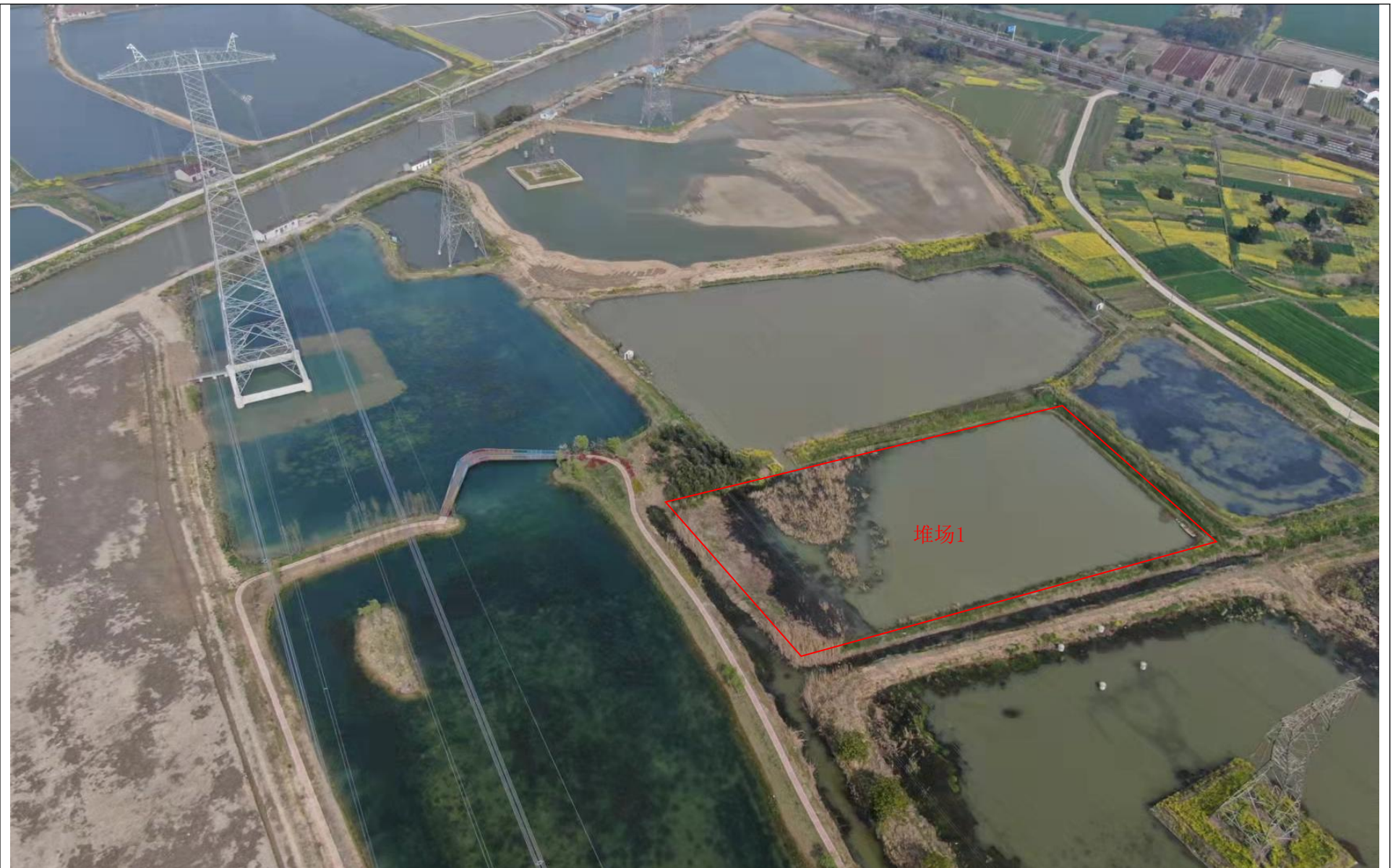
农业面源氮磷生态拦截净化工程堆场1现状
