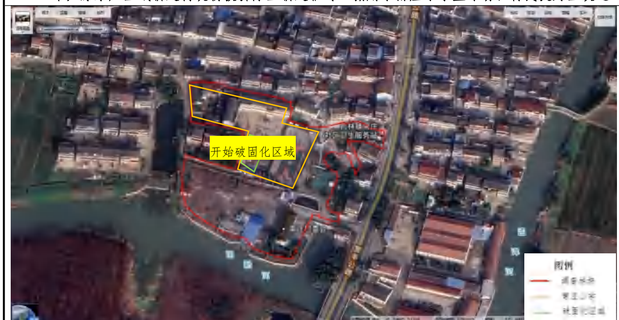
2020年，改建南庄村党群服务中心工程开始，南庄小学操场开始破固化
