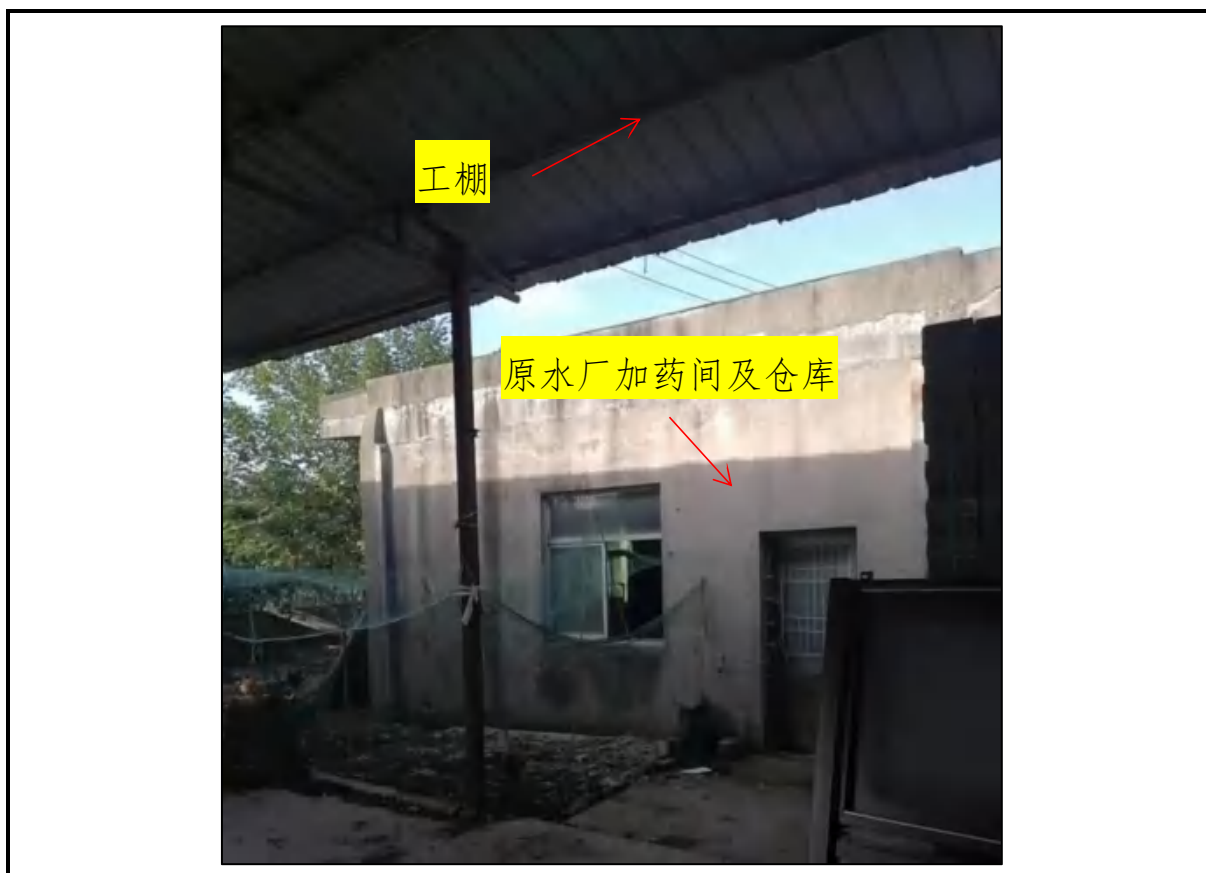
图 4.3-8 原宜兴市丰义自来水厂加药间及仓库构筑物
