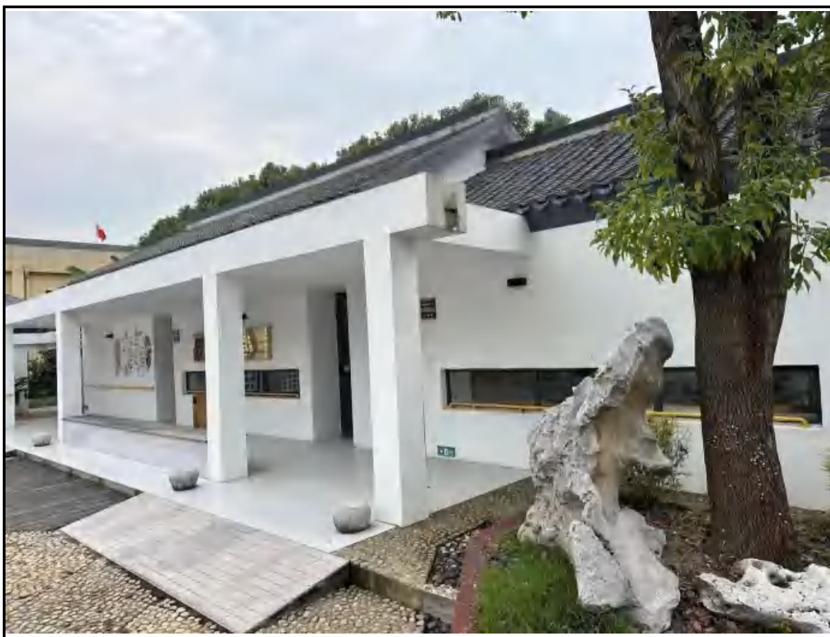
图 4.3-1 南庄村党群服务中心居家养老服务站
