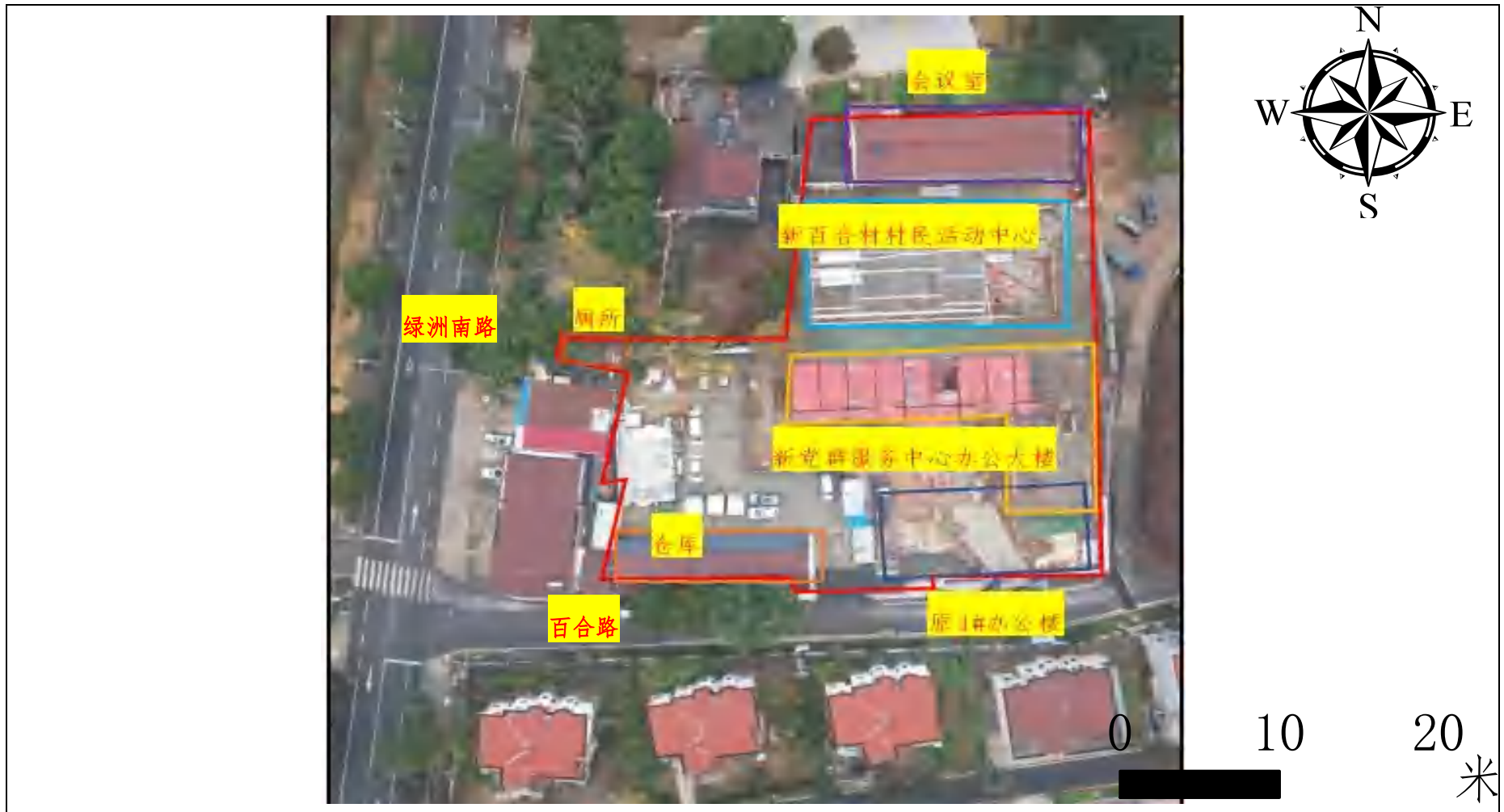
图 2.1-4 项目地块现状航拍图
